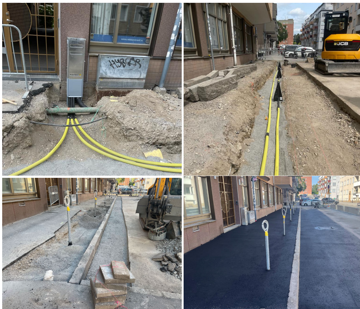
Figur 5.6: Schaktning för Starrbäcksgatans laddstation. Övre bilderna: vårt mätarskåp ansluts till Vattenfalls elskåp bredvid och gula rör med elkabel leds till laddstolparna. Ett av rören läggs tomt för möjlig utökning av fler laddstolpar. Observera kantsten som lyfts bort. Nedre: kantsten återsätts, grus fylls över laddstolparna som förberetts med kablage och slutligen asfaltering.
